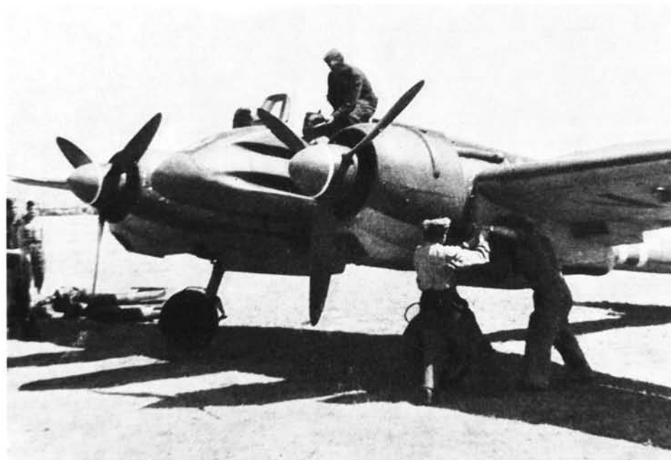
Przygotowanie do startu. Rozruch silnika samolotu Hs 129B-2, samolot posiada „długie” rury wydechowe typowe dla wczesnych serii produkcyjnych. Samolot pomimo użytkowania w jednostce bojowej (SchG 2) nadal posiada namalowane pod skrzydłami oznaczenia tzw. kodu radiowego („V”), front wschodni, 1943 rok? [Der Adler]
